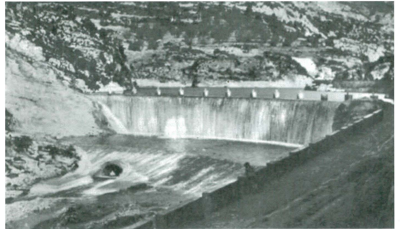
Presa de l'embassament d'Ulldecona (anys 40)
